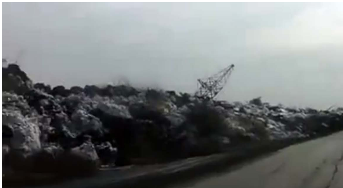
Рисунок 1 – Последствия оползня на отвале участка «Заречный»
