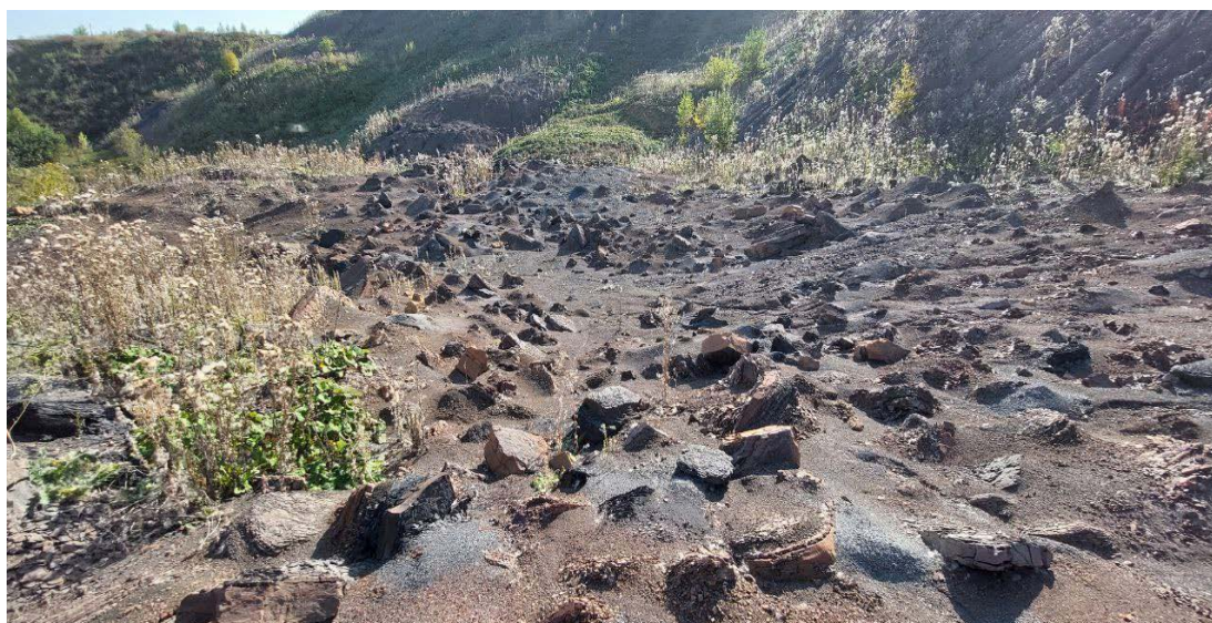
Рисунок 3 – Состояние пород в теле отвала, сформировавшееся в результате их выветривания под действием атмосферных осадков и изменения температуры
